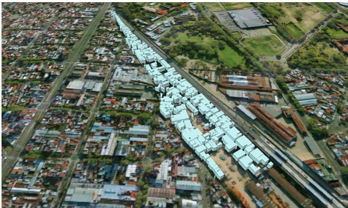
Edificación en La Carbonilla – Vista desde el Este
