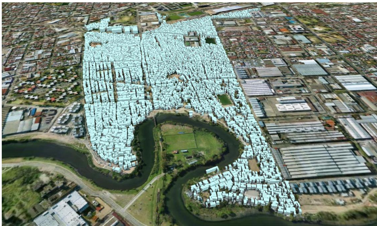
Edificación en Villa 21-24/Zavaleta – Vista desde el Sur
