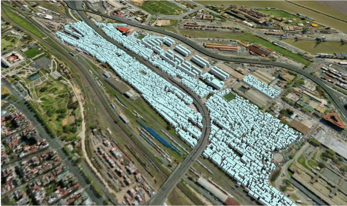
Edificación en Villa 31 y 31 bis – Vista desde el Sur
