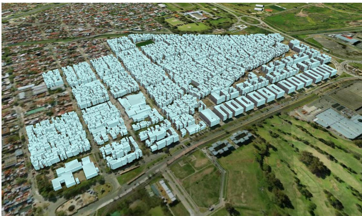
Edificación en Barrio 20 – Vista desde el sur
