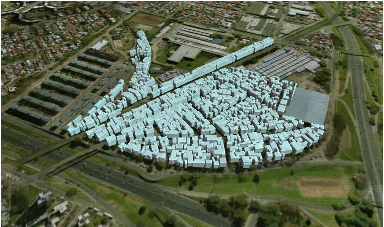
Edificación en Barrio Inta – Vista desde el Oeste
