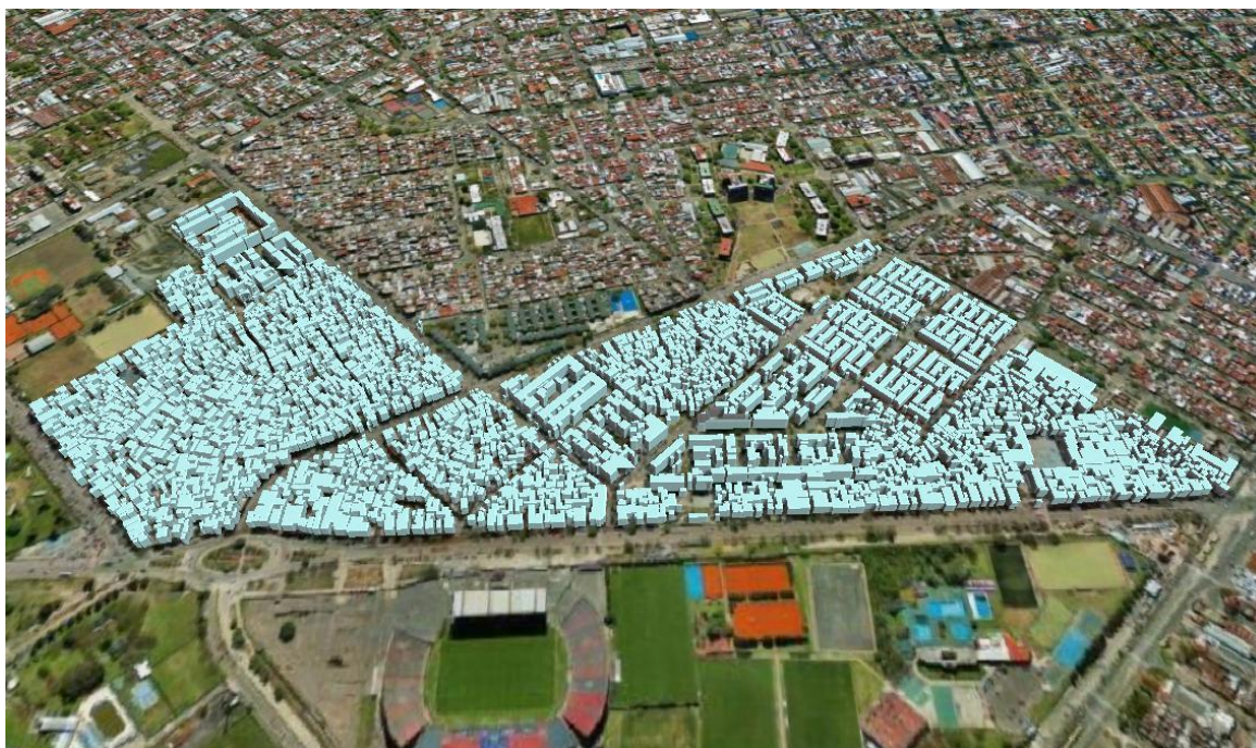
Edificación en el barrio Ricciardelli/1-11-14 – Vista desde el Sur
