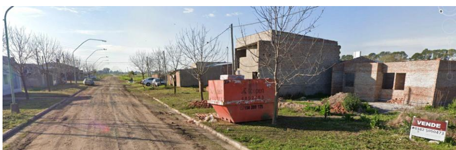
Zona de expansión al norte (2025) – Se puede observar la venta de lotes y la construcción de viviendas unifamiliares en proceso
