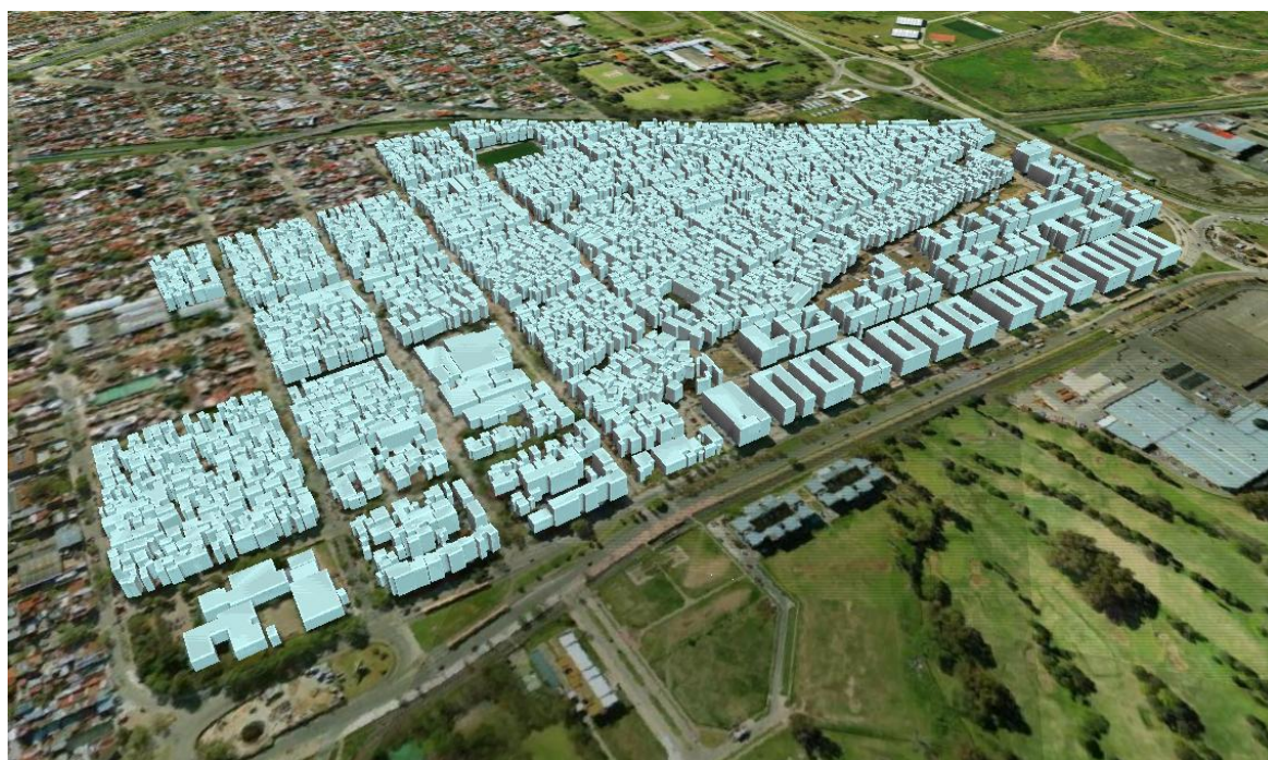
Edificación en Barrio 20 – Vista desde el sur
